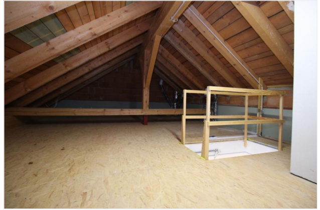
Abstellraum im Speicher - Zugang von der Wohn
